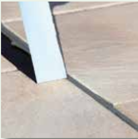
Klebebänder direkt im Anschluss entfernen
