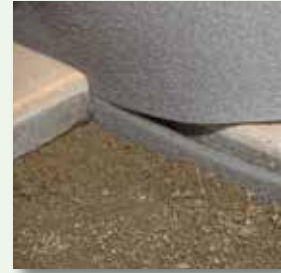
vdw 884 FugenBand 10 mm tief abtrennen
