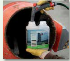
Max. 1 l Wasser hinzufügen und homogen anmischen
