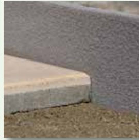
Anschließenden Belag druckfrei verlegen
