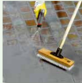
diagonal zur Fuge abreinigen
