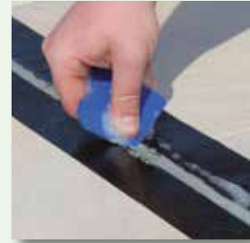
Fugenmasse verdichten und abziehen
