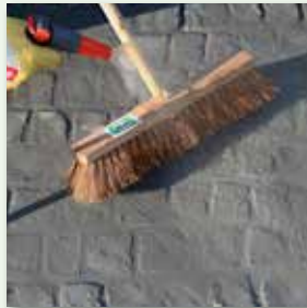
Erhärten des Mörtels auf der Oberfläche vermeiden
