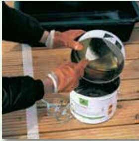
Frühestens nach 4 Stunden die Komponenten der Decksicht wie die der Schwimmschicht aufmischen
