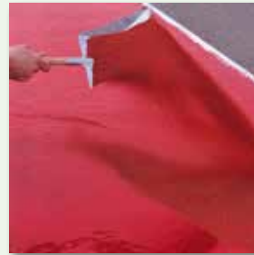
Im frischen Zustand mit Abstreusand abstreuen
