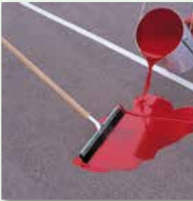
Material vollständig ausbringen und mit Gummischieber verteilen
