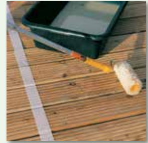
Mittels Fellrolle verteilen
