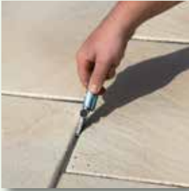
Hierzu Schnittkante FugenBand einkerben
