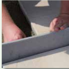
vdw 884 FugenBand im Bettungsmörtel einbringen
