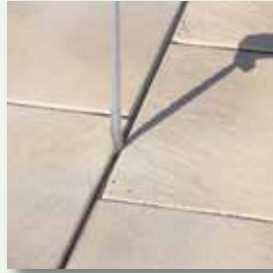
Fugenbandreste komplett entfernen
