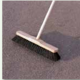
Untergrund sorgfältig vorbereiten
