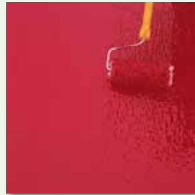
Mittels Malerrolle nacharbeiten
